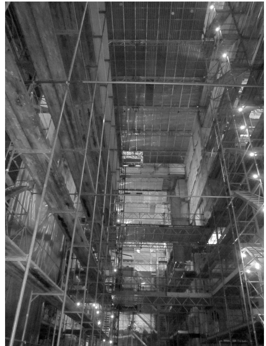
Der eingerüstete Kirchenraum. Oben die Arbeitsplattform für die Gewölbe
